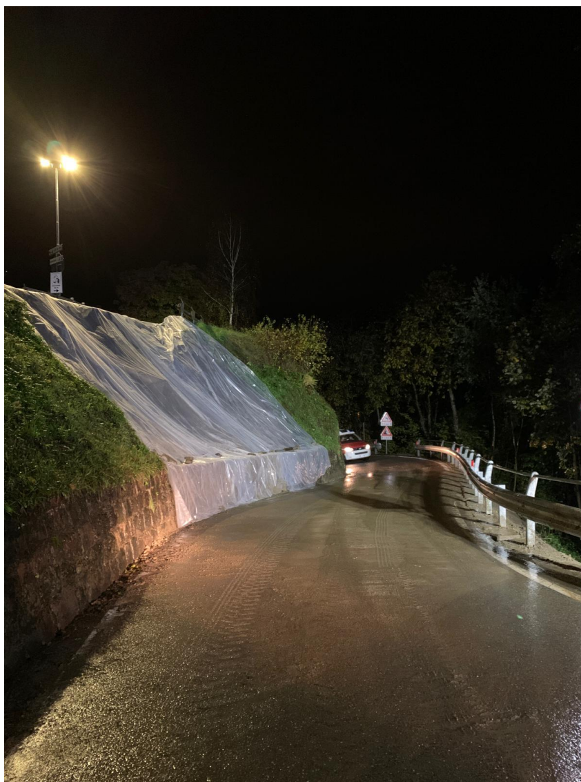
Area interessata dal cedimento vista dalla S.P. 135 sinistra Fersina ad intervento completato.
